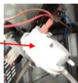
Presostat komina w kotle.
