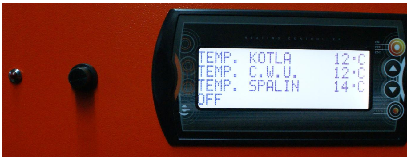
Obrázok 1: Pohľad na ovládací panel kotla. Na ľavej strane je čierny kryt prepínača STB.
